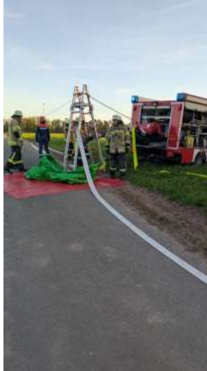
Aufbau des Wasserbeckens
