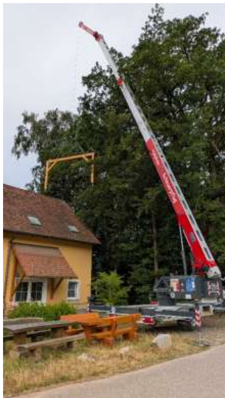
Der Kran hebt die Teile hinter das Haus
